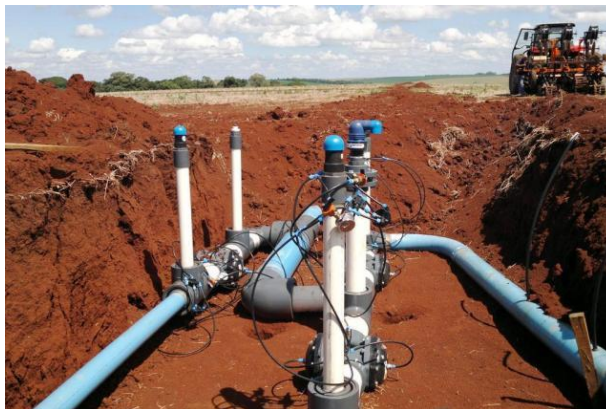
Figura 2.6 - Construção de sistema de irrigação subterrânea (Witter, 2012).
