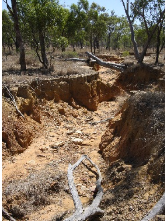
Figura 4. Voçoroca. Fonte: Queensland (2015).
