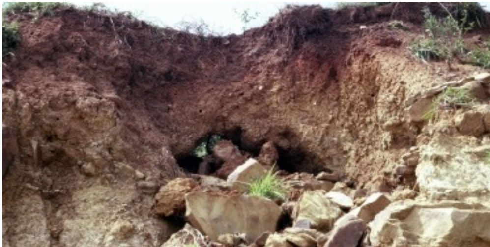
Figura 5. Erosão em túnel. Fonte: Queensland (2015).
