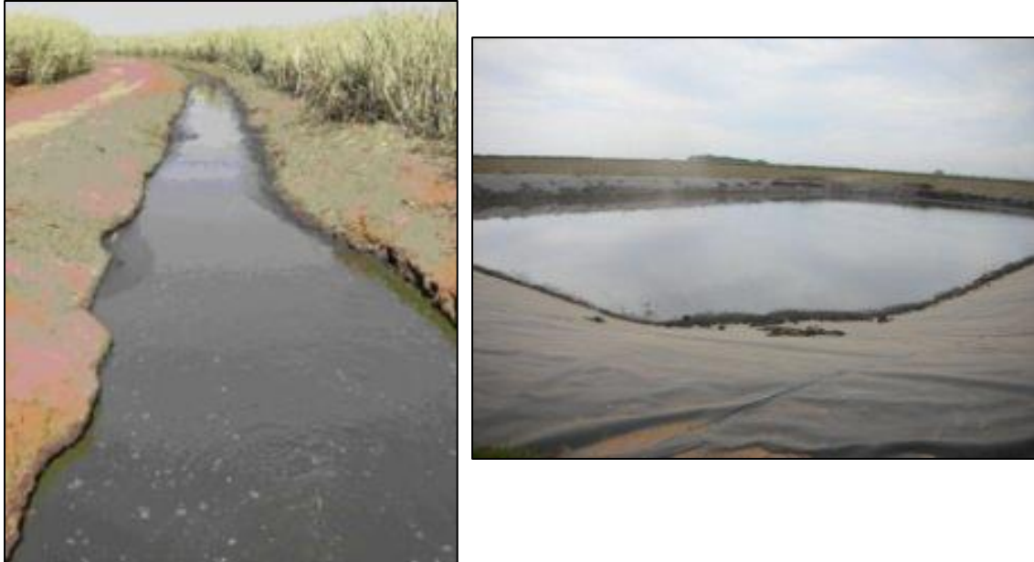
Figura 8 – Canal de vinhaça e tanque impermeabilizado para deposição de vinhaça (Fonte: Agência Embrapa - AGEITEC).
