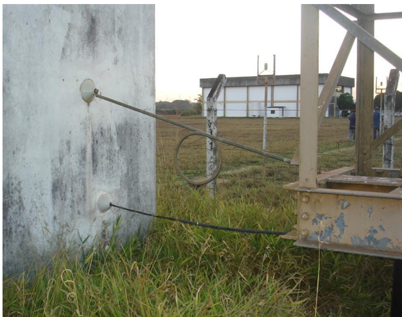
Fig. 5.6. Conexão do casador com a torre.
