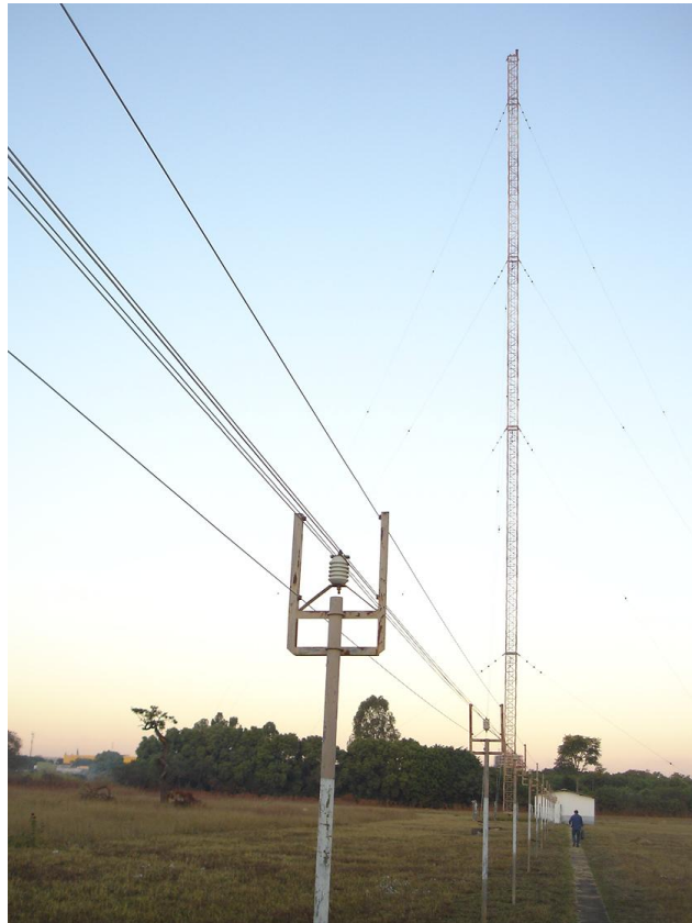
Fig. 5.3. Linha de transmissão, abrigo do casador e a torre.
