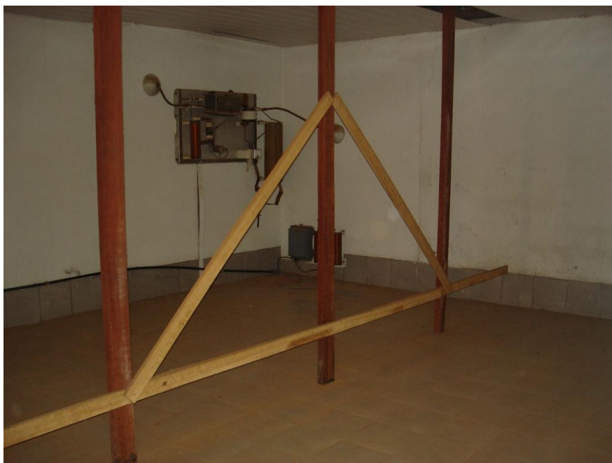
Fig. 5.4. Parte interna do abrigo.
