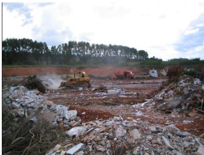
Figura 22- Vista geral da área reservada à disposição do RSCD dentro do aterro do Jóquei Fonte : (Rocha,2006)
