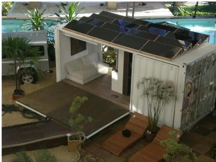
Figura 3. 29 Casa container com painéis fotovoltaicos (ZOMER, 2009).
