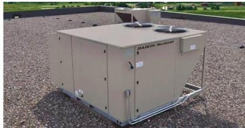
Figura 2. 5 Ar-condicionado *roof top* (FORATO, 2012).
