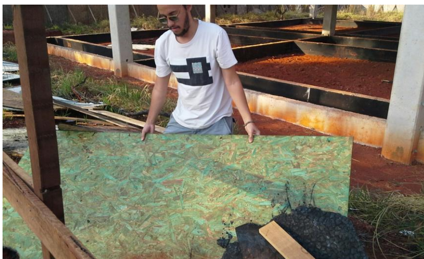
Figura 24 – Augusto Botelho. Canteiro de obras na UnB. Arquivo pessoal. 2015.
