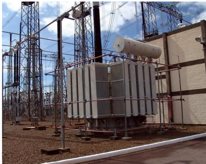
**Figura 2.1** - Reator *shunt* de 765 kV na subestação de Foz do Iguaçu.
