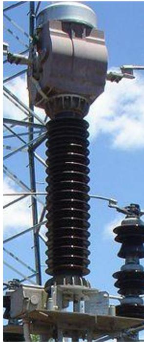
**Figura 2.7** - TC tipo barra de 138 kV.
