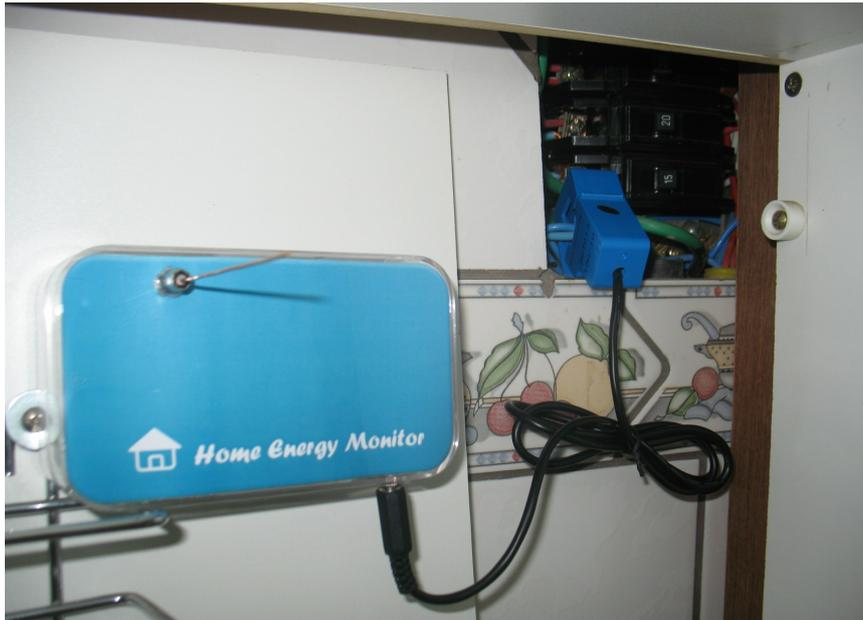
Figura 4.23: Conexão do sensor em um quadro elétrico.
