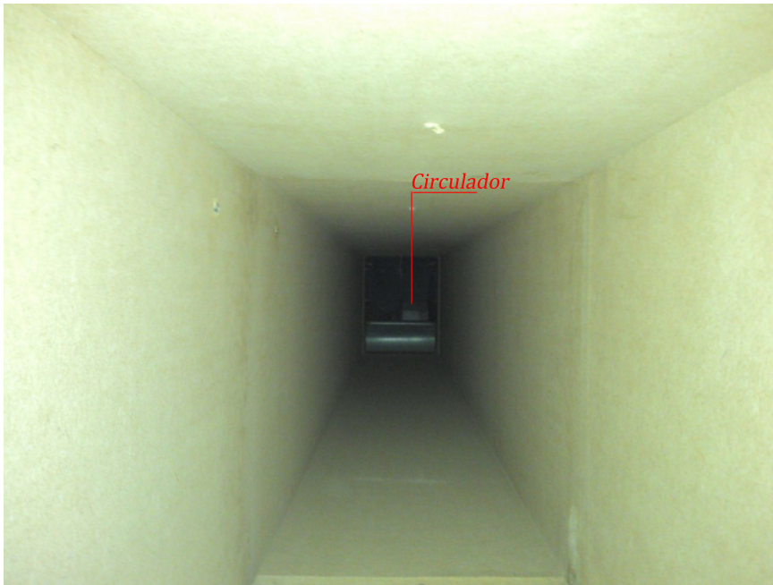
Figura 4.10: Interior do Túnel.
