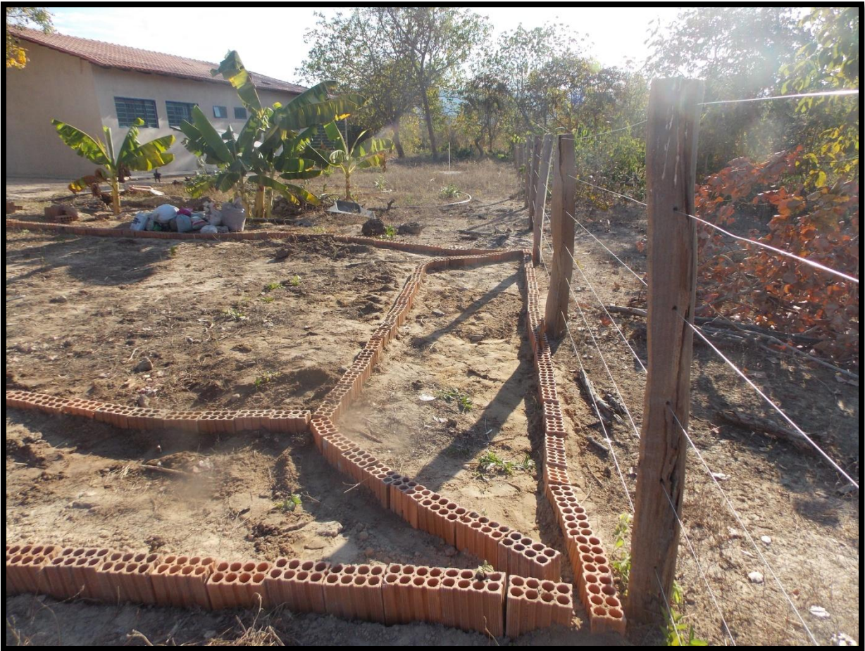
Foto 4 – Horta da Escola Santo Antônio – em construção
