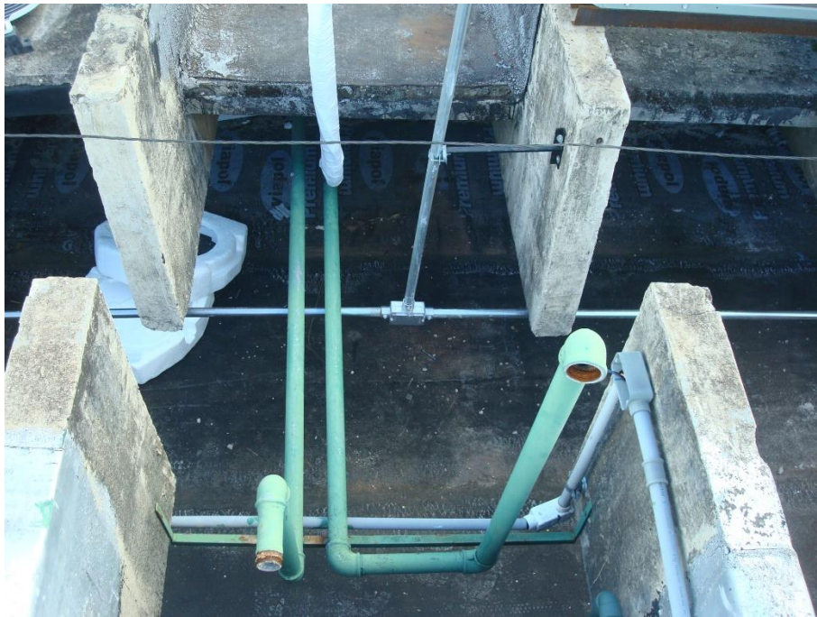
Figura 2.10. Laje do SG-09, onde se encerra a tubulação.
