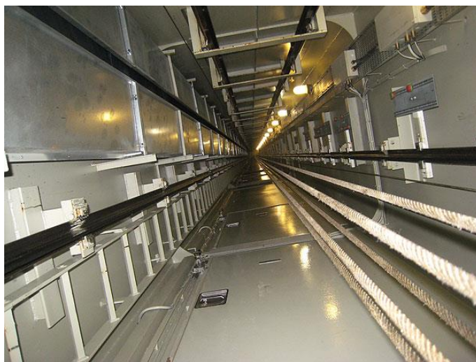
Figura 1.2. Interior de uma caixa de elevador. [4]
