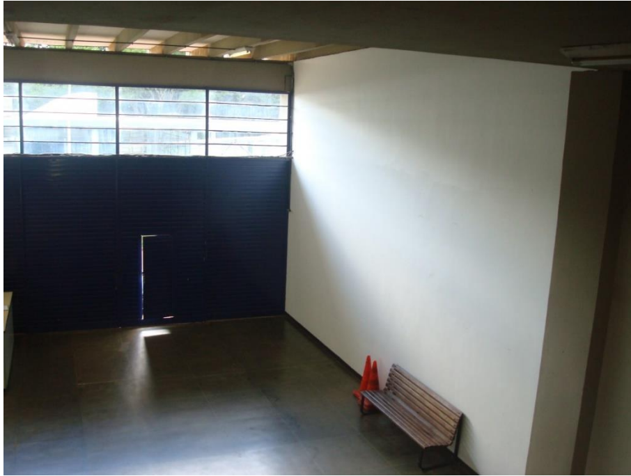
Figura 2.14. Terceiro local considerado para instalação do elevador.
