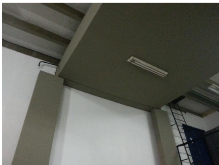
Figura 2.2. Parede lateral esquerda da área de entrada.
