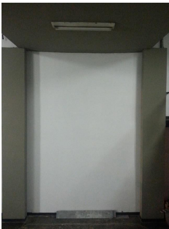
Figura 2.3. Parede lateral esquerda da área de entrada, vista frontal.
