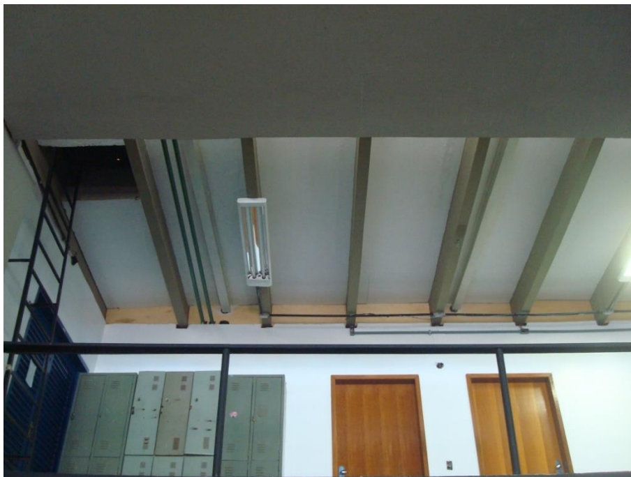
Figura 2.9. Teto do SG-09, com tubulação verde visível à esquerda.
