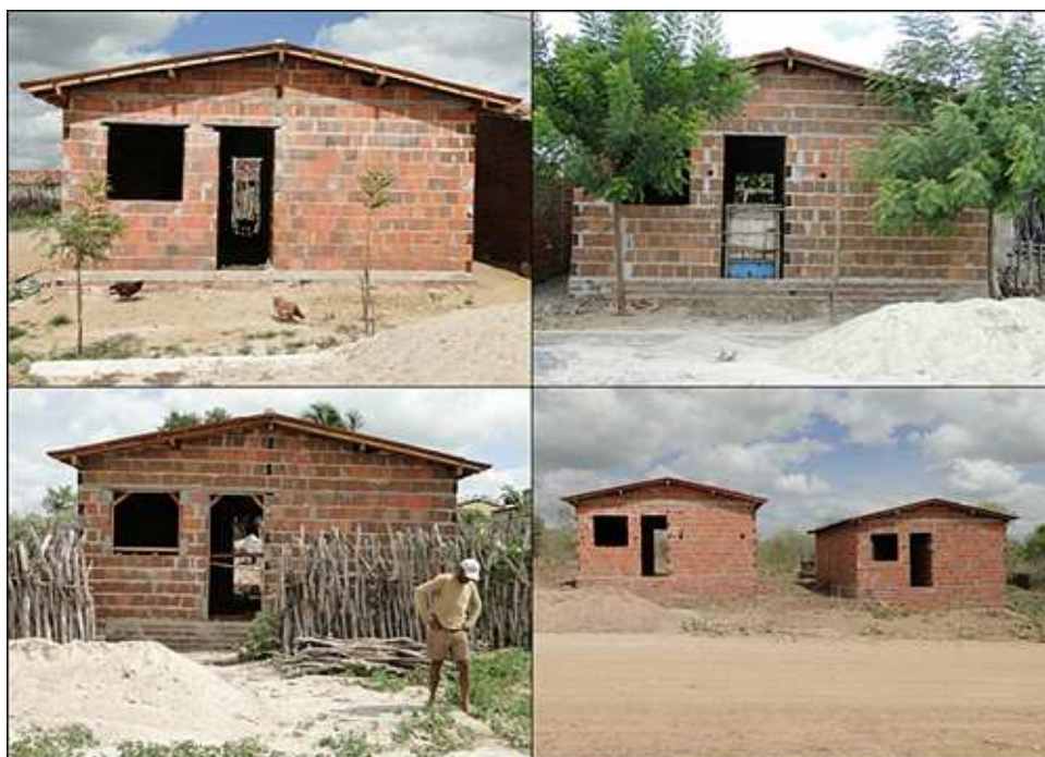
Exemplares de unidades habitacionais do Programa Nacional de Habitação Rural-PNHR sendo construídas no distrito de Alto dos Honório, Município de Cariré
