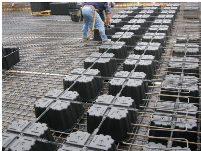
Figura 2.10. Sistema construtivo de lajes U-boot<sup>®</sup> (fonte: <http://br.daliform.com>)
