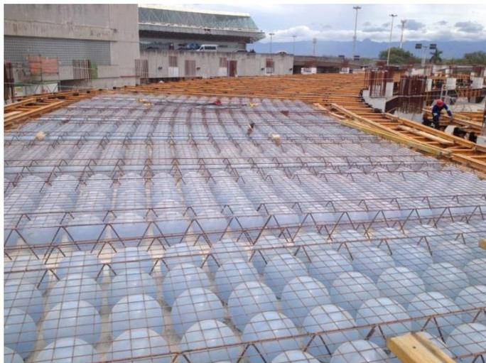
Figura 2.15. Construção Edifício Garagem Galeão - Rio de Janeiro (RJ) (fonte: Apresentação BubbleDeck®)
