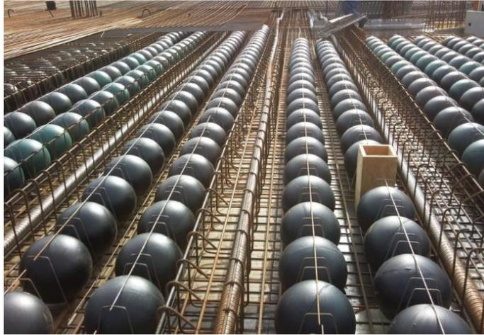
Figura 2.5. Sistema Construtivo Cobiax® com módulos esféricos (fonte: <http://www.ferca.pt/>)
