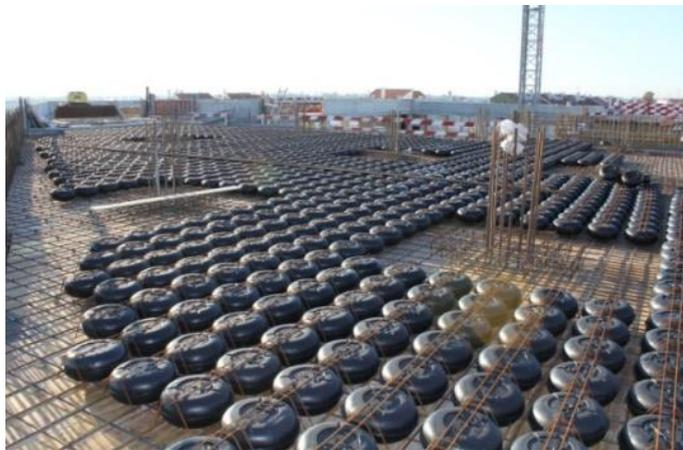
Figura 2.6. Sistema Construtivo Cobiax® com módulos elípticos (fonte: <http://www.ferca.pt/>)
