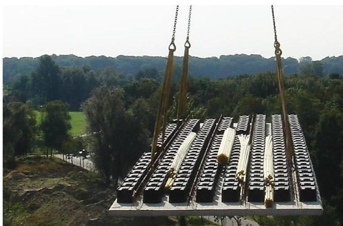
Figura 2.2. Laje do tipo Airdeck® (fonte: <http://www.airdeck.com>)
