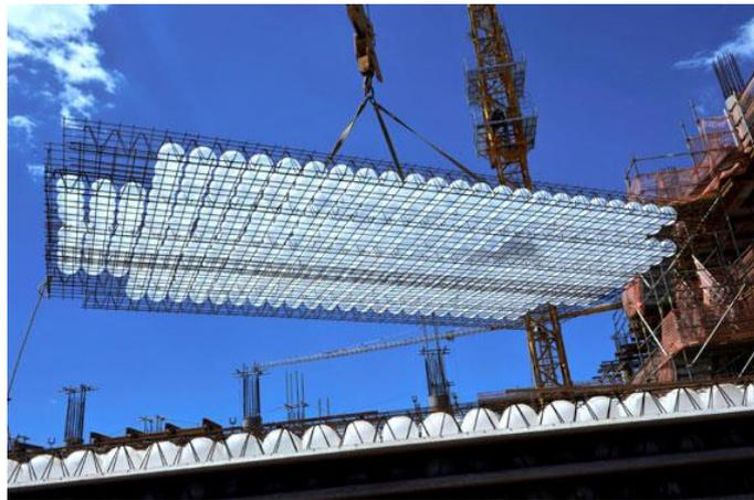
Figura 2.11. Lajes *BubbleDeck*® (fonte: Apresentação Bubbledeck®)
