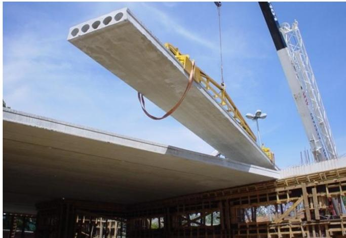
Figura 2.16. Transporte de painel de Laje Alveolar (fonte: [www.protensul.com.br](http://www.protensul.com.br))
