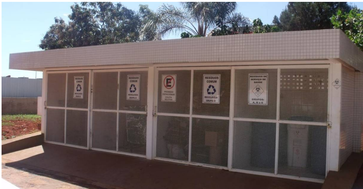
Figura 6.1 – Acondicionamento final de resíduos hospitalares
