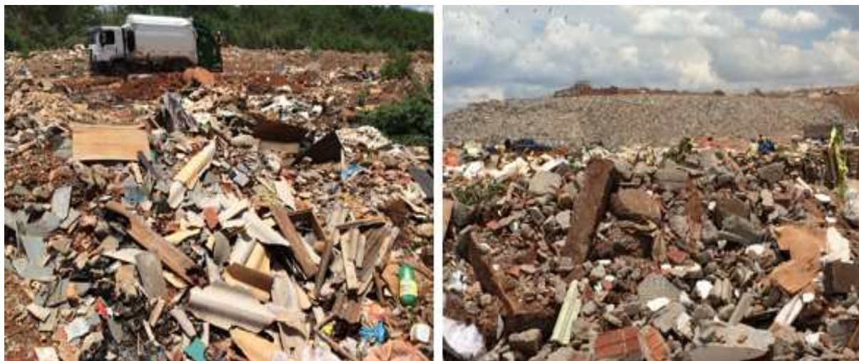
Figura 6.9 – Aterro do Jόquei.
