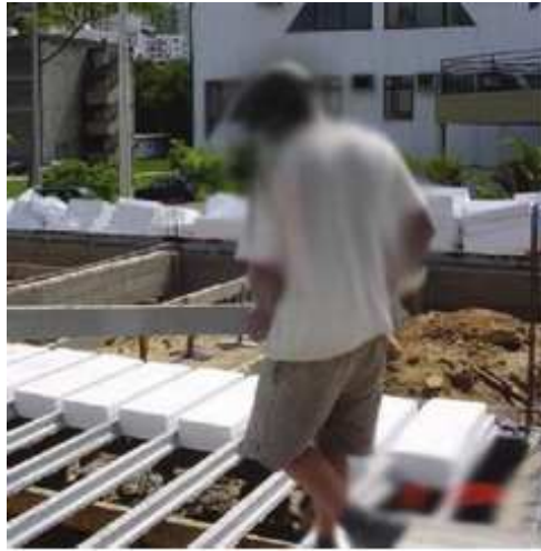
Figura 2.16 – Laje pré-moldada com EPS (Bourscheid, 2010).
