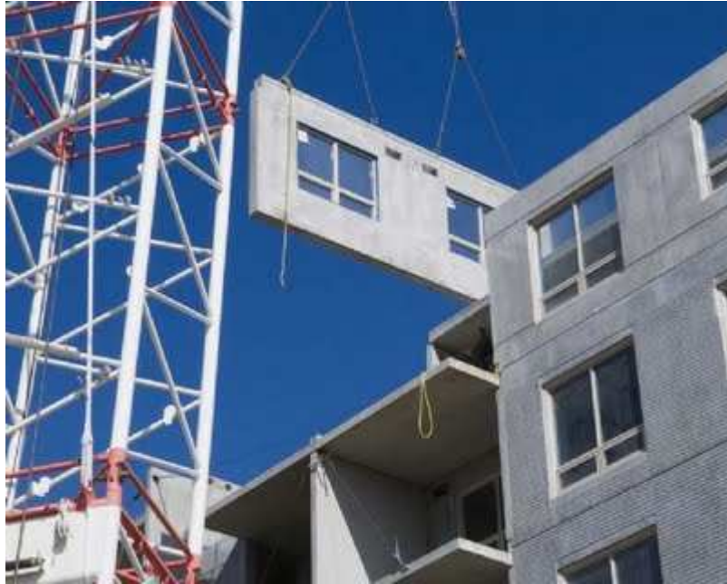
Figura 2.18 – Alvenaria de vedação pré-moldada (www.cadernodaconstrucao.com.br, 2013).
