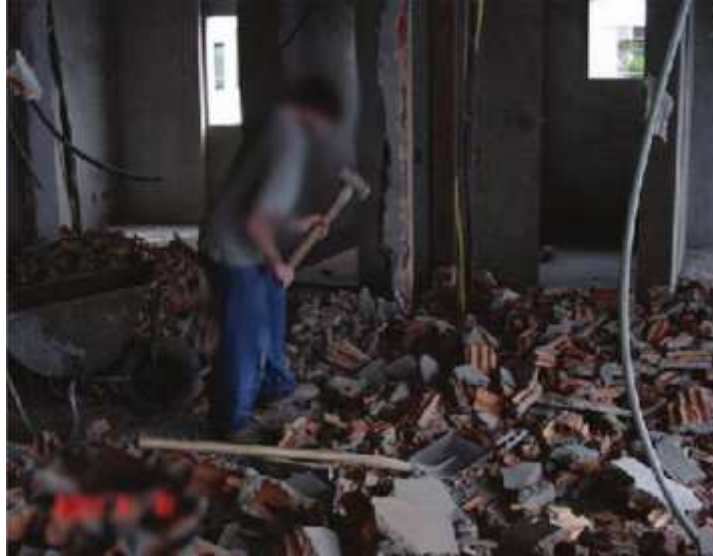
Figura 2.14 – RCC gerados por uma parede demolida (Bourscheid, 2010).
