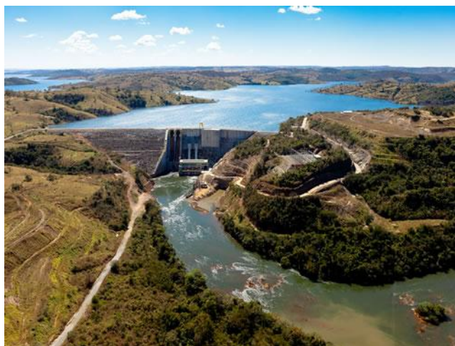
Figura 3-1: Barragem Serra do Facão - Vista frontal (Serra do Facão Energia S.A.)
