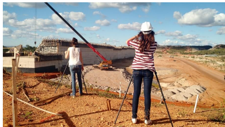
Foto 5: Filmagens da obra em Brejo Santo (CE)
