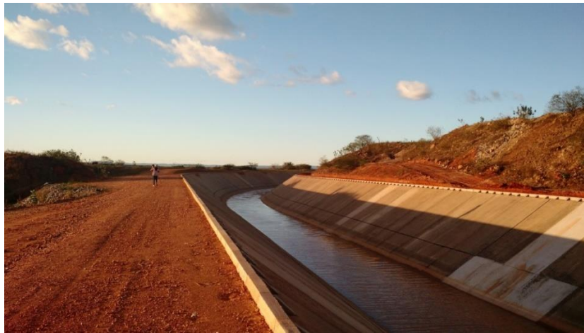
Foto 7: Canal da transposição no trecho de Brejo Santo (CE)
