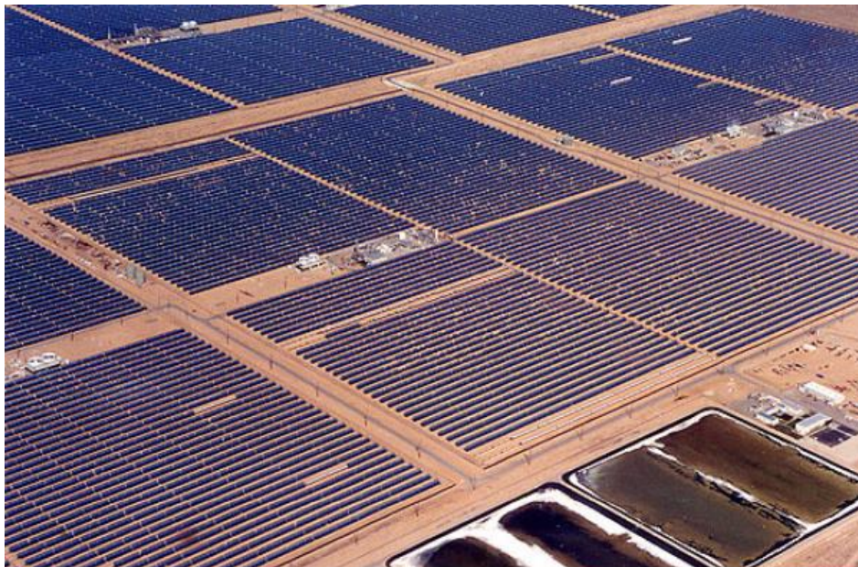
Figura 14. Central SEGS, sectores III até VII. [15]
