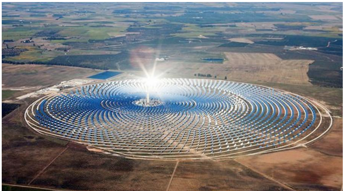
Figura 9. Central GEMASOLAR, Fuentes de Andalucía, Espanha.
