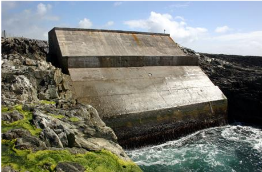
Figura 15 – Central LIMPET, instalada na Ilha de Islay, Escócia (Voith, 2013)
