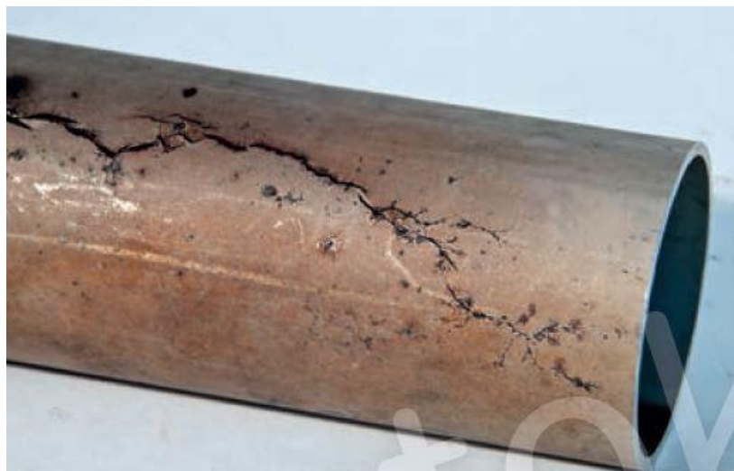
Figura 2-8 Corrosão sob tensão no aço inoxidável (OUTOKUMPU, 2013)
