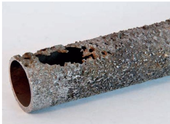
Figura 2-3 Corrosão uniforme em uma tubulação ( OUTOKUMPU, 2013 )
