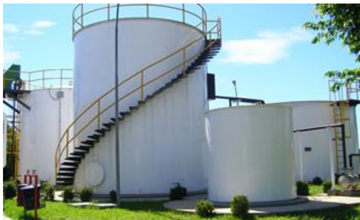
Figura 13. Estação de tratamento de efluentes industriais na AmBev.
