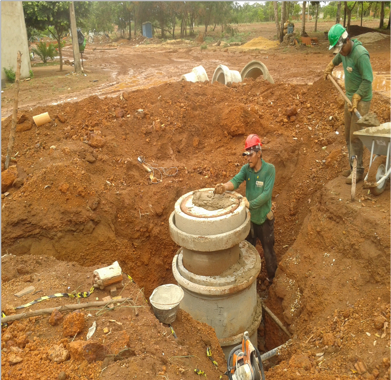
Figura 9 - Quadra 1.304 Sul- Obra de Esgotamento Sanitário.
