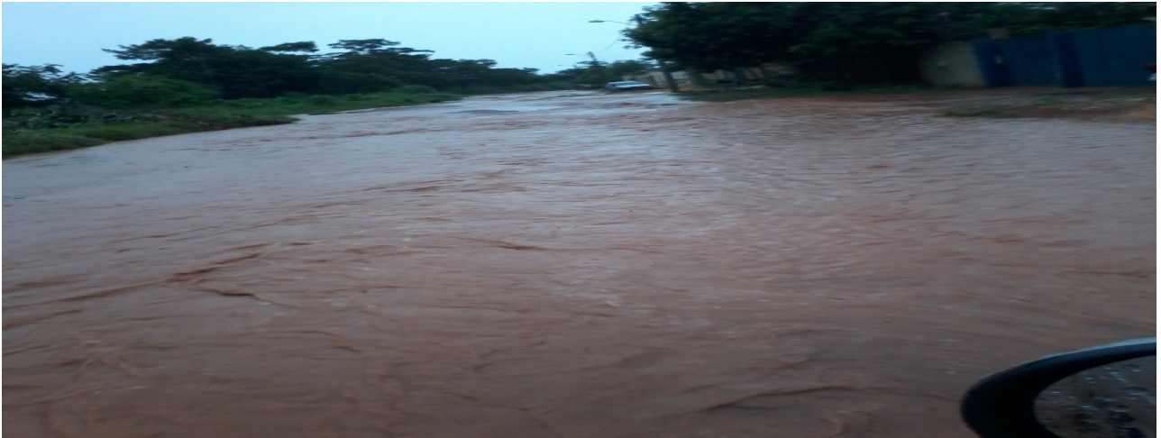
Figura 22 - Quadra 1.304 Sul-Pontos de Alagamentos.
