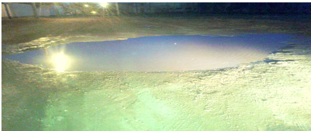
Figura 21 - Quadra 1.304 Sul-Pontos de Alagamentos.
