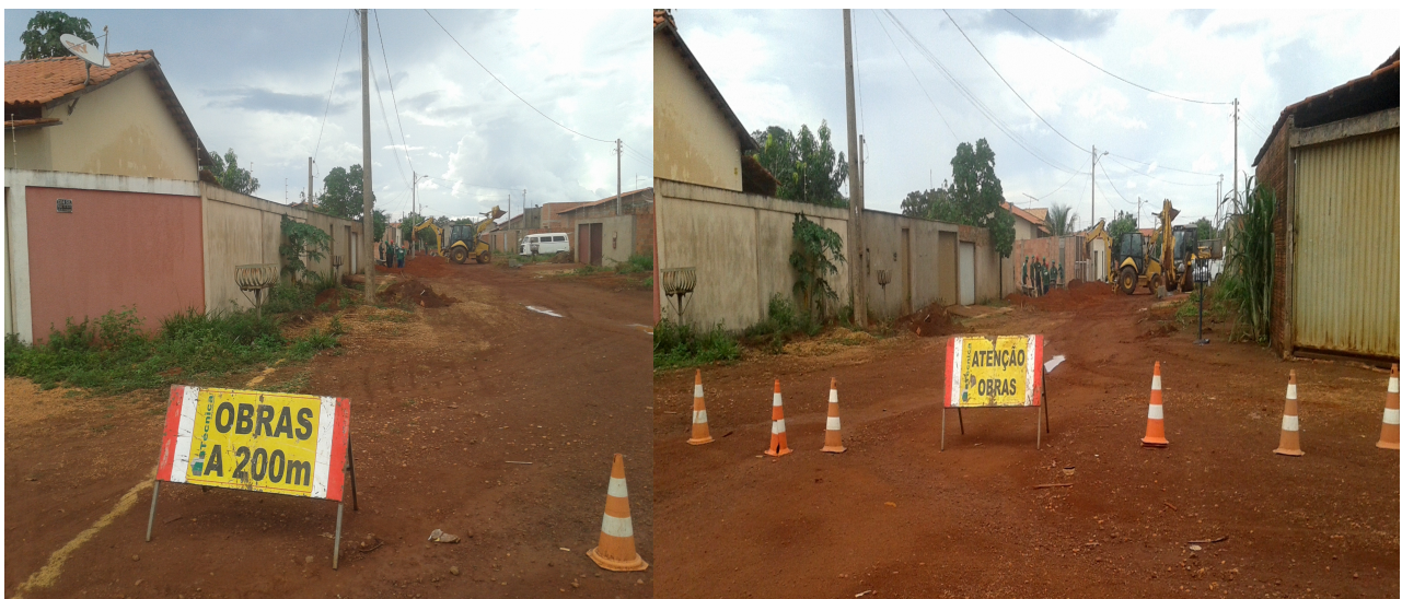
Figura 23 - Quadra 1.304 Sul- Obra de Esgotamento Sanitário.
