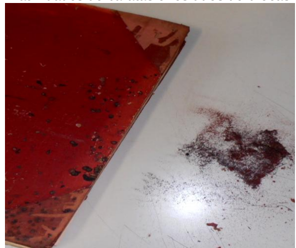
Figura 27 - Manchas provocadas por atividades de baratas e resíduos de brocas
