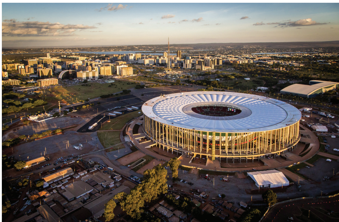
Figura 3 Estádio Mané Garrincha
