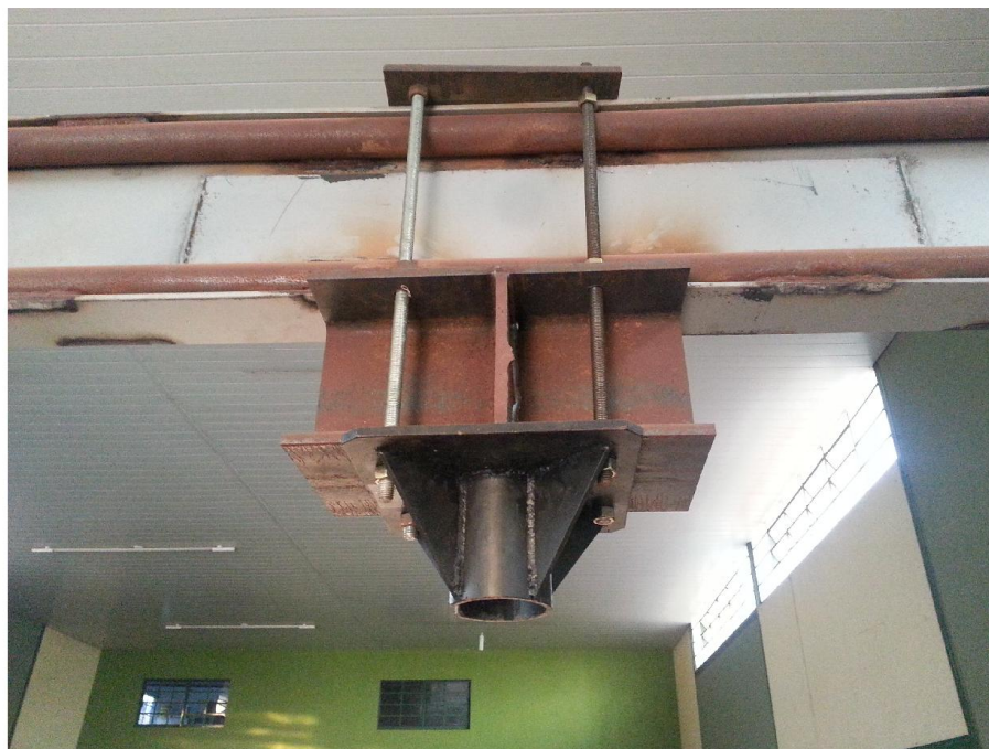
Figura 51 – Exemplo do suporte utilizado para fixação do pistão.
