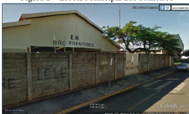
Figura 2 – Escola Municipal São Francisco
