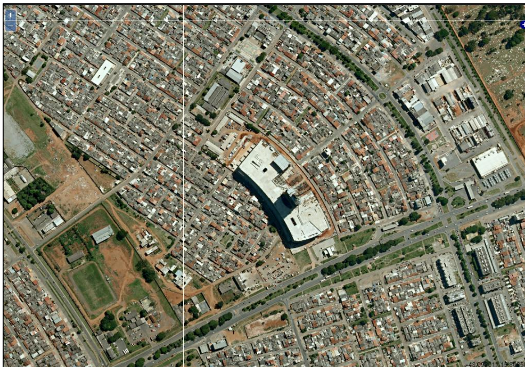
Figura 15: Imagem de satélite situando o empreendimento na fase de construção. À direita do shopping está a “Velha Mnorte” e à esquerda a “Nova M Norte”. Fonte: Geo serviço- Codeplan,2014.
