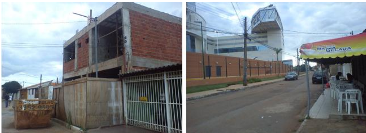
Figura 13: À direita na imagem, a sorveteria localizada próxima ao JK Shopping. E à esquerda o pequeno edifício comercial onde a sorveteria será realocada. Fonte: autoria nossa.
