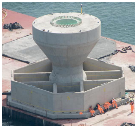
Figura 5.4 - Peça da base de gravidade de uma turbina éolica offshore . (No Tíree Array, 2011)
