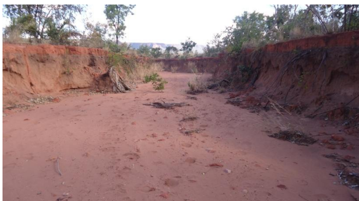
Figura 10. Efeito erosivo causando assoreamento ao rio São Domingos. (Foto do autor – 30/06/2014)
