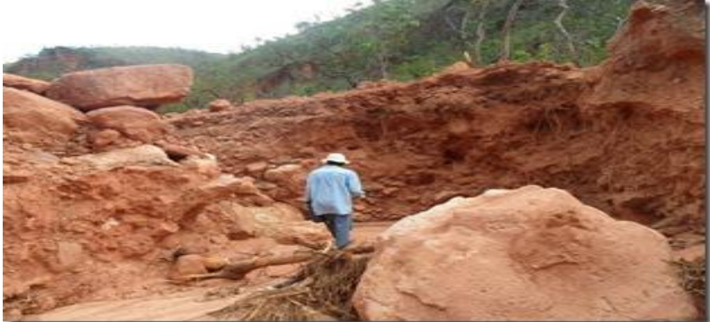
Figura 2. Cratera aberta pelas águas das chuvas na Serra geral em São Domingos/GO
