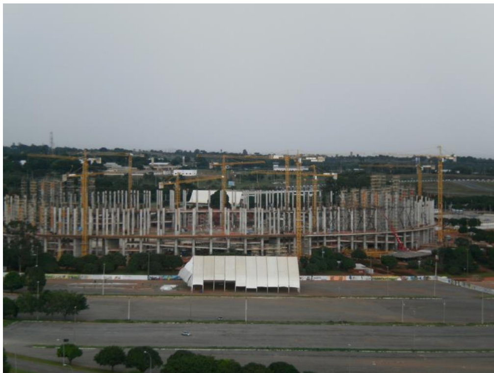
Figura 2: Estádio Nacional de Brasília. Fevereiro de 2012/Fonte: Próprio Autor
