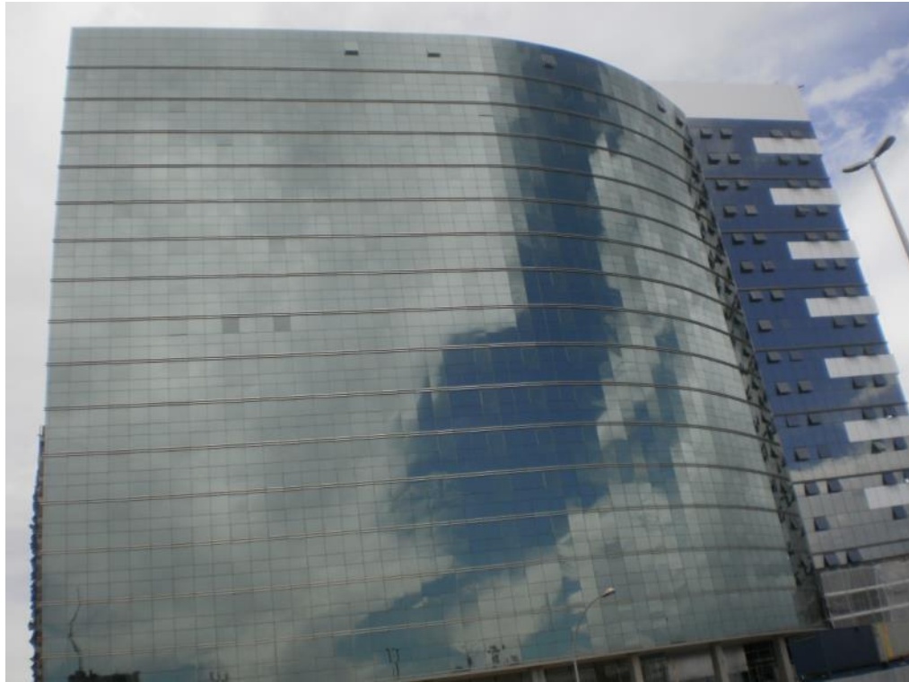
Figura 29: Hotel Le Quartier. Setor Hoteleiro Norte. Fevereiro de 2013/Fonte: Próprio Autor
