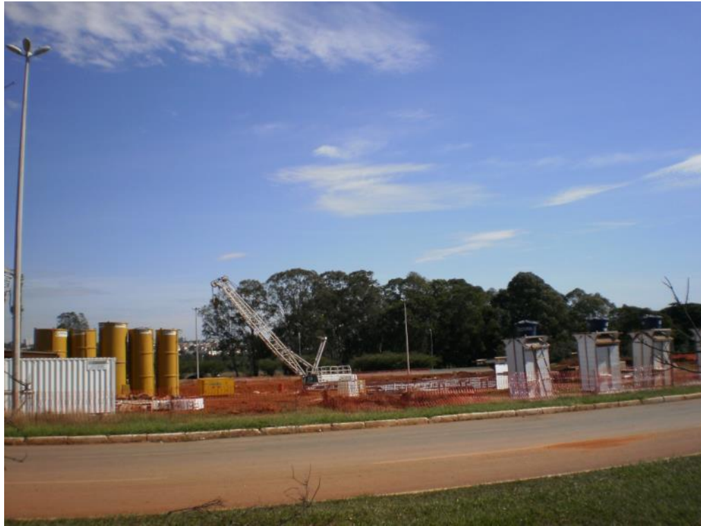
Figura 15: Ampliação da DF-047. Junho de 2013/Fonte: Próprio Autor
