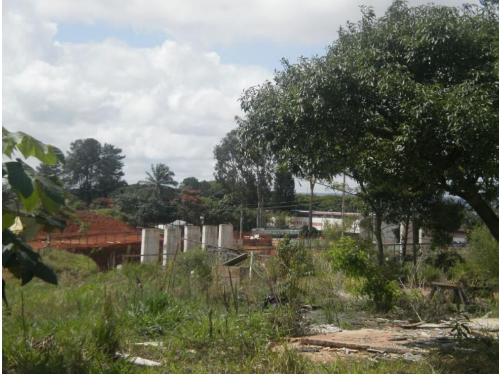
Figura 11: Obras do VLT. Novembro de 2012/Fonte: Próprio Autor
