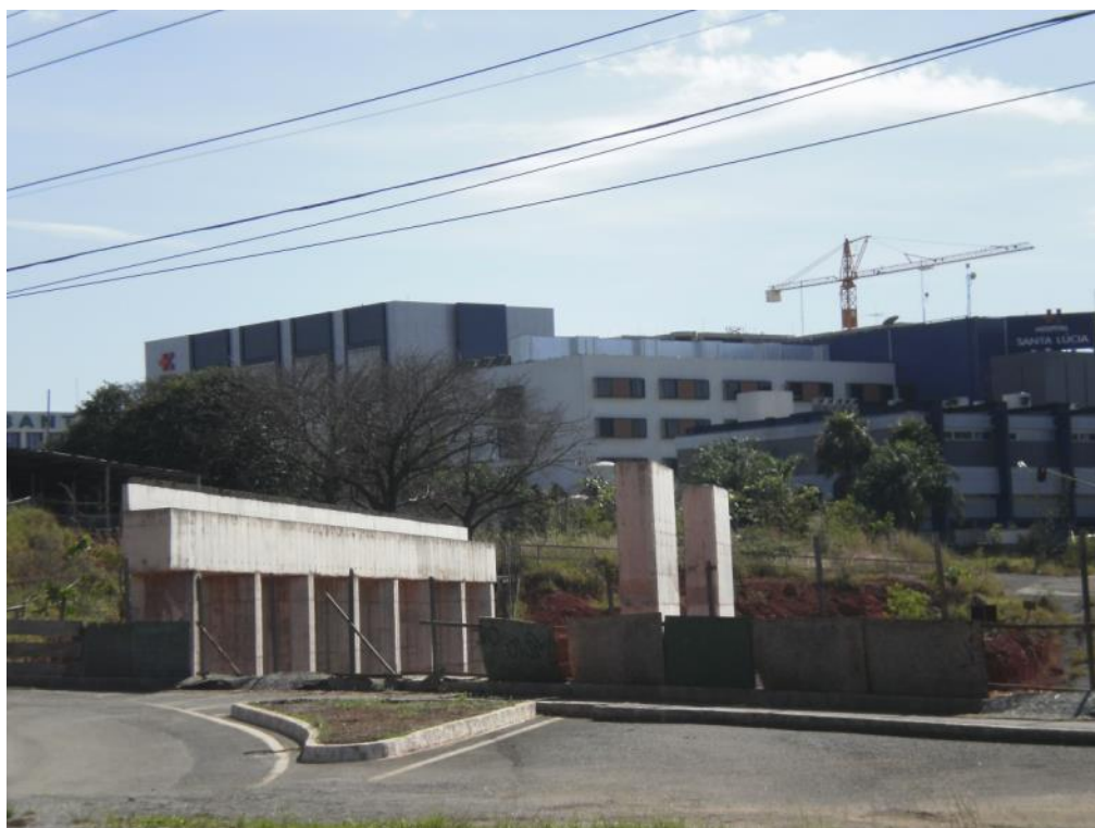
Figura 14: Obras do VLT. Junho de 2013/Fonte: Próprio Autor
