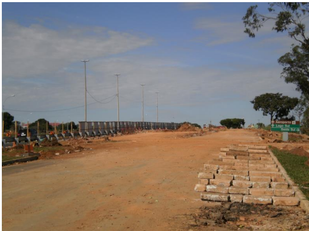
Figura 16: Ampliação da DF-047. Junho de 2013/Fonte: Próprio Autor
