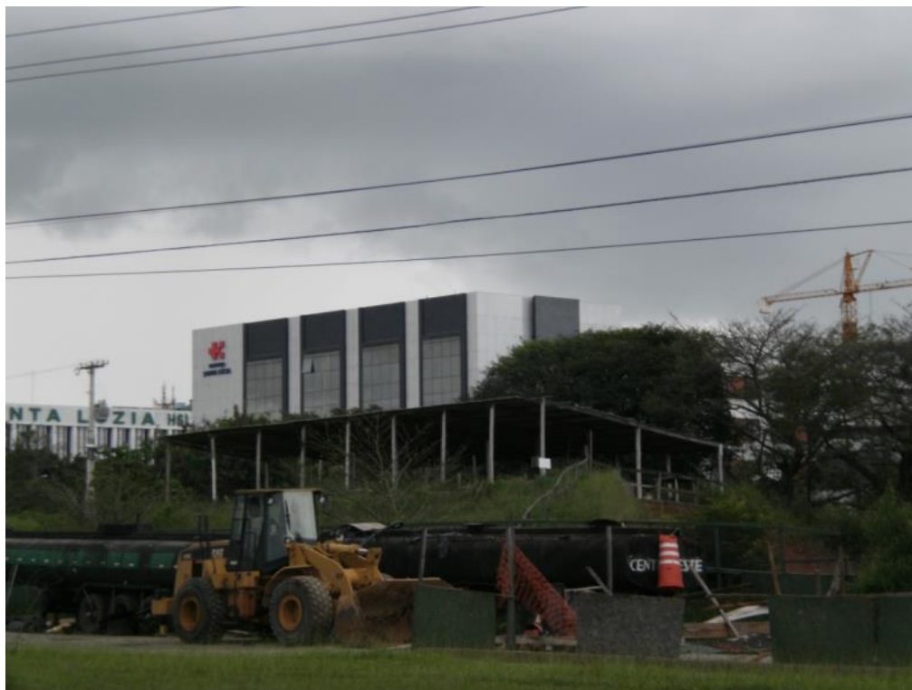
Figura 13: Obras do VLT. Maio de 2013/Fonte: Próprio Autor
