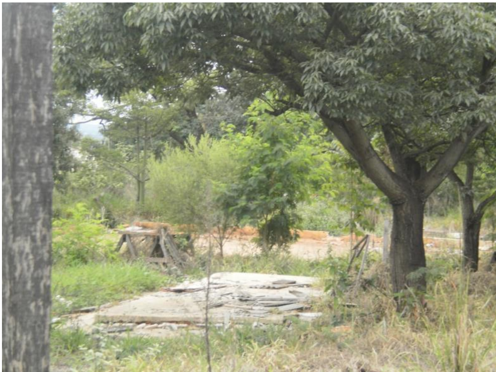
Figura 12: Obras do VLT. Fevereiro de 2013/Fonte: Próprio Autor
