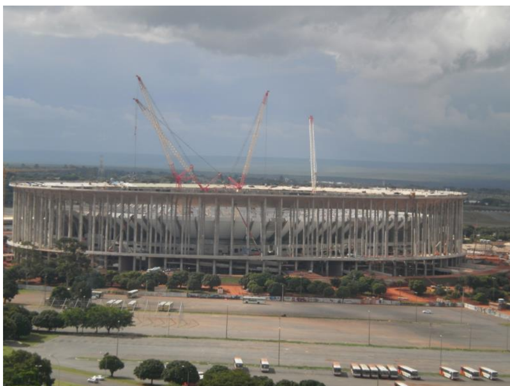
Figura 7: Estádio Nacional de Brasília. Fevereiro de 2013/Fonte: Próprio Autor
