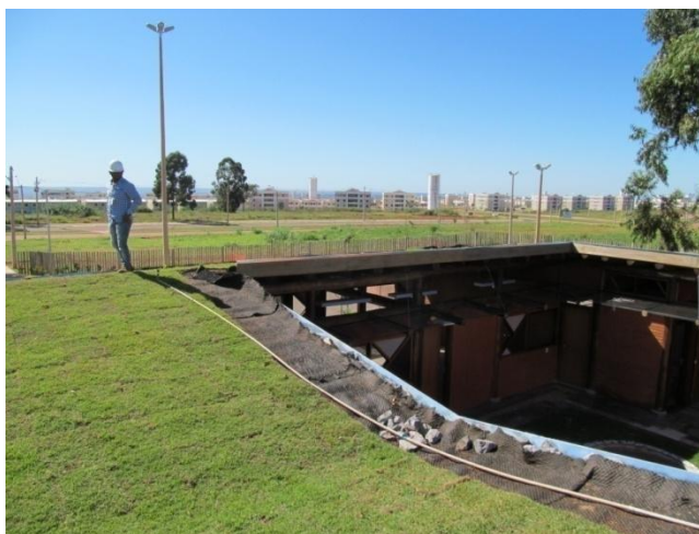
Figura 13. Telhado verde no Centro de Práticas Sustentáveis – São Sebastião, DF
