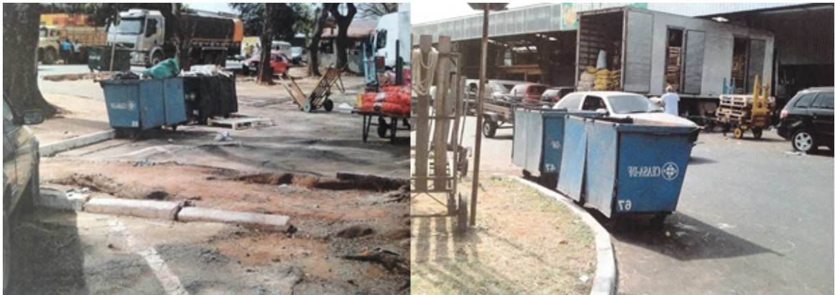
Figura 6- Contêineres mal posicionados e transbordando na CEASA-DF
