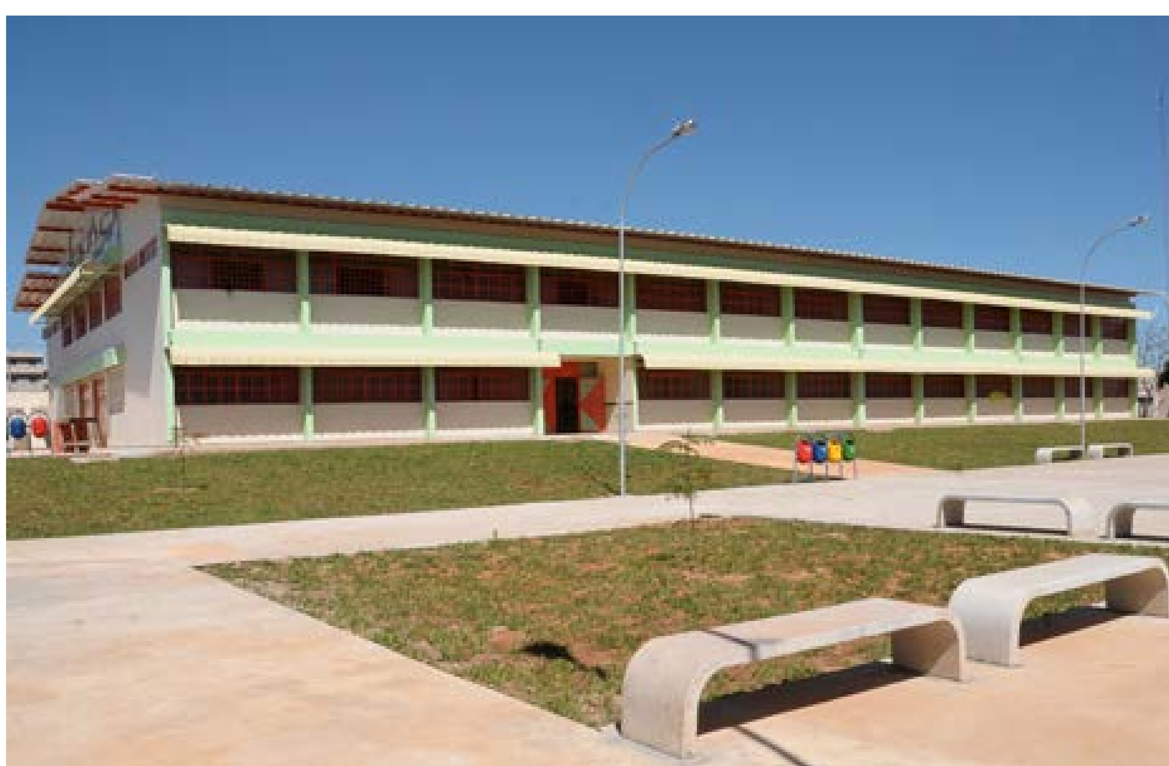
Figura 1 – Fachada Externa da Escola
