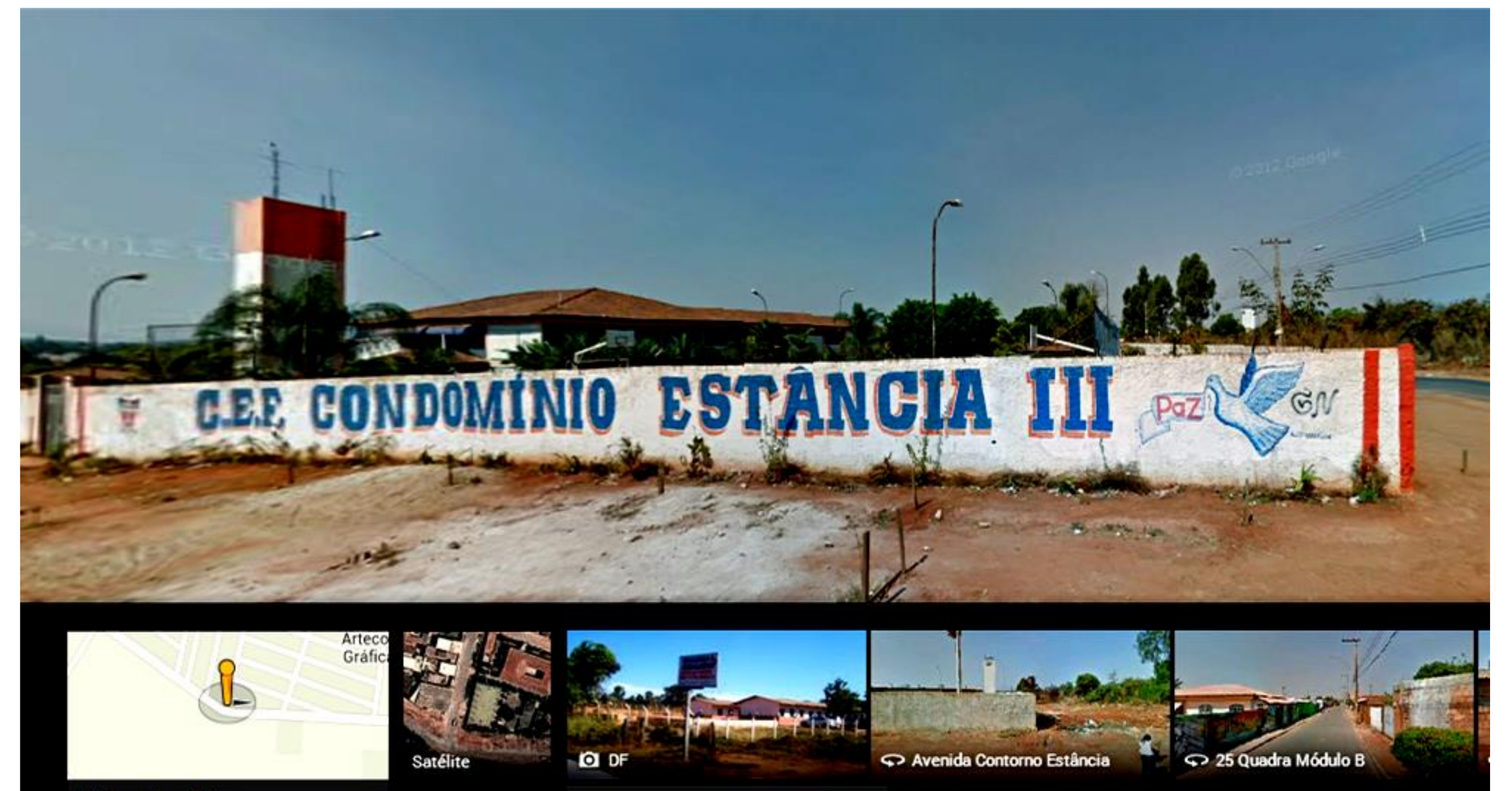
Figura 2 – Área do CED Condomínio Estância III, https://goo.gl/maps/tsGha , em 30 mar. 2014
