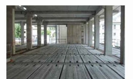
Imagens do elemento pré-fabricado de concreto armado alveolar e de seu uso em obras
