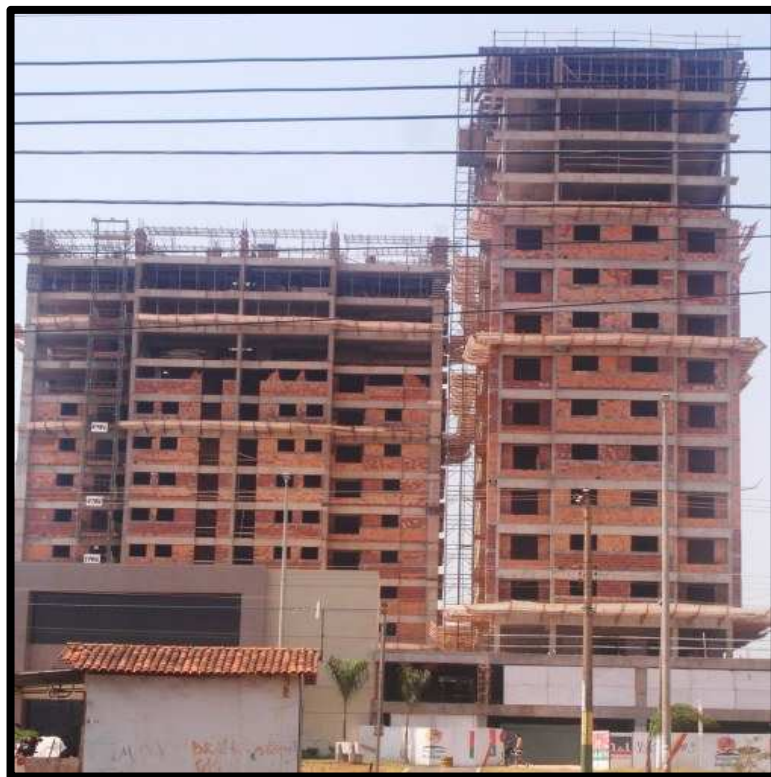
Figura 3. Construção civil destinada à habitação nas proximidades de Brasília, desenvolvidas para condomínios. Imagem: Clay Rodrigues, 2011.
