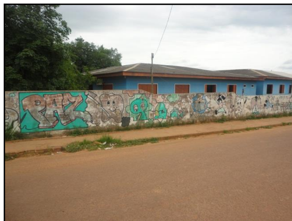
Figura 5 - Muro da Escola Mª de Fátima - Bairro Vitória/Sena Madureira
