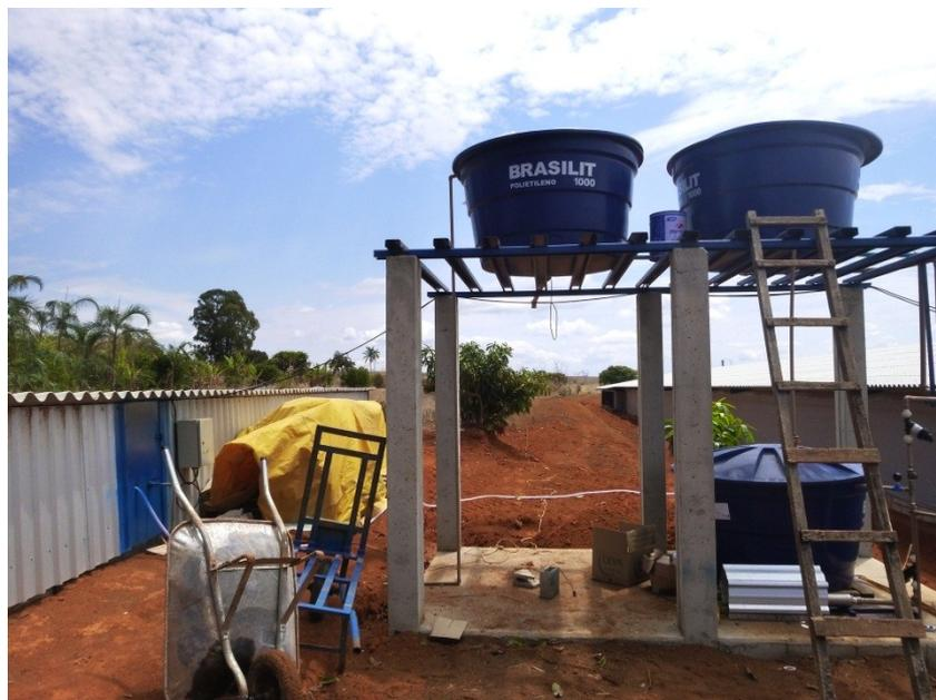
Figura 17. Caixas d'água. As situadas na parte de baixo correspondem ao sistema de nebulização, enquanto as de cima armazenam a água de bebida.
