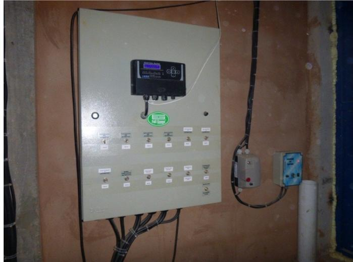
Figura 18. Painel de controle dos sistemas de ventilação e nebulização de aviários de pressão negativa.
