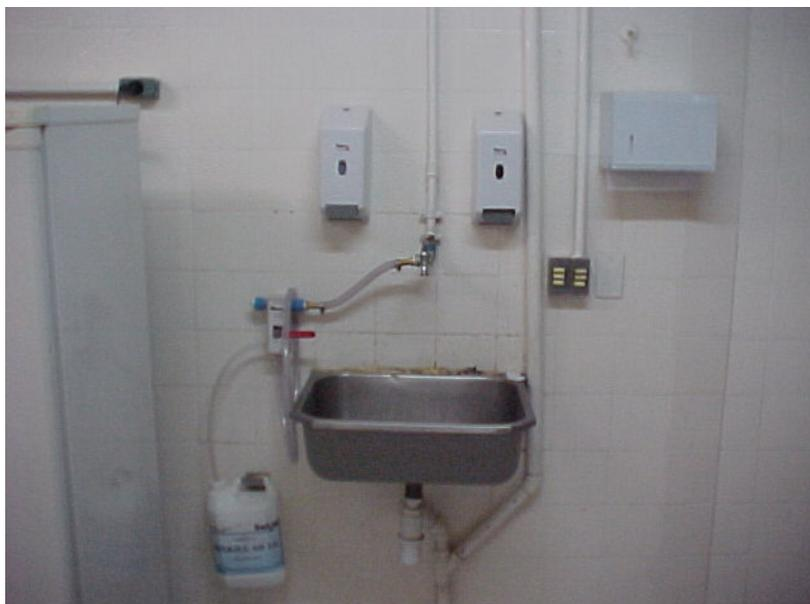
Figura 3 – Produto específico de higienização de superfícies, instalado com diluidor.
