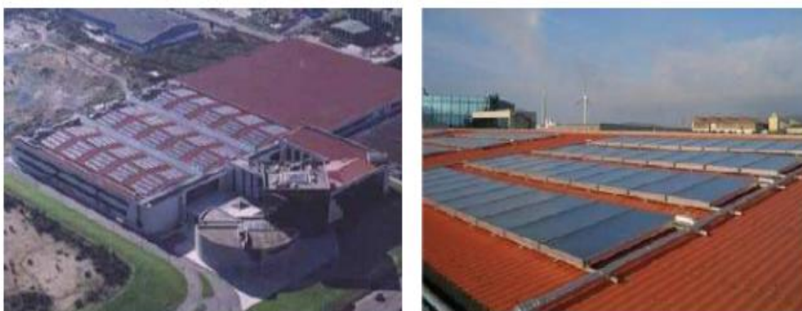
Figura 2.1 - Edifício com sistema de ar condicionado alimentado com energia solar (NTT, 2010).
