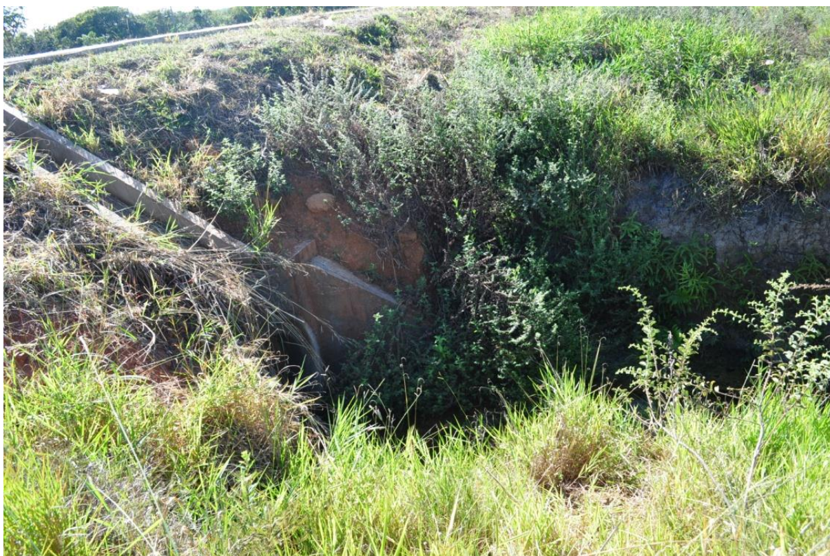
Figura 13 – Registro fotográfico de um dos canais que drenam as águas das áreas de Campo, de pastagem e de agricultura para a sub-microbacia do Córrego Brejinho (Lima, F. A. S. 23/05/2012).
