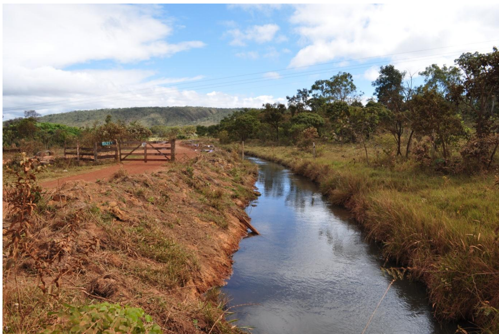
Figura 1 – Registro fotográfico de canal que leva as águas do Ribeirão Pípiripau até o núcleo rural Santos Dumont. (Lima, F. A. S. 23/05/2012).
