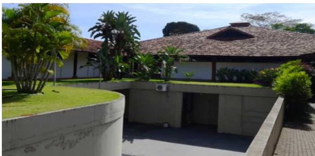
Figura 45 - Bloco E: Rampa de Acesso ao Subsolo
