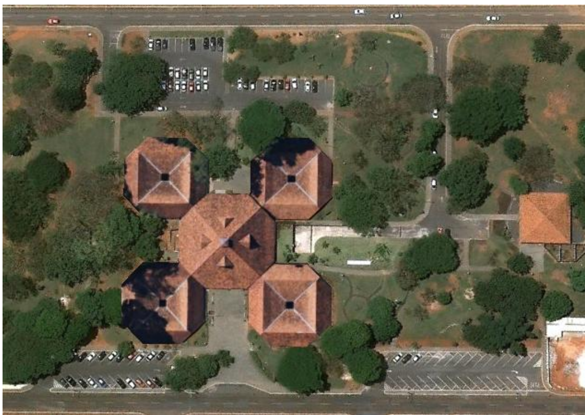
Figura 22 - Vista Aérea do Centro de Excelência em Turismo da UnB (Google,2012)
