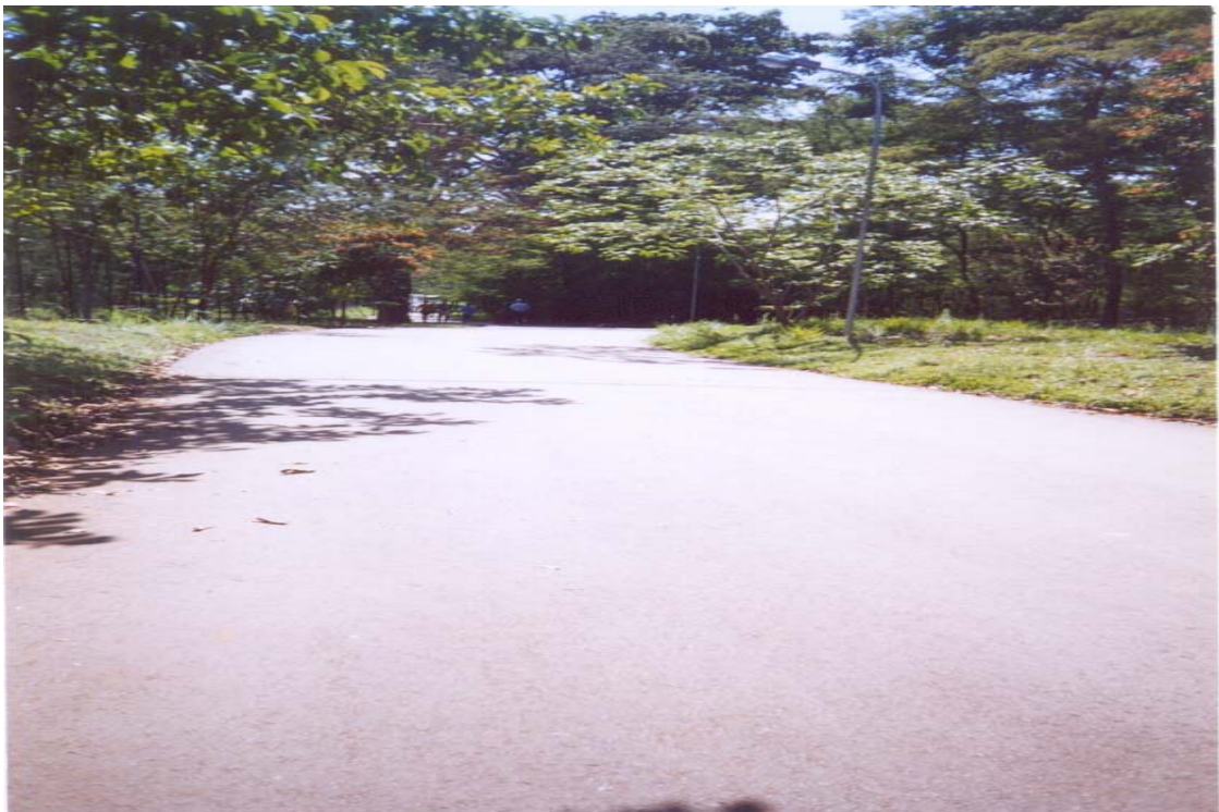
Figura 03 : Trilha de pavimentação asfáltica com 3 mil metros de extensão
