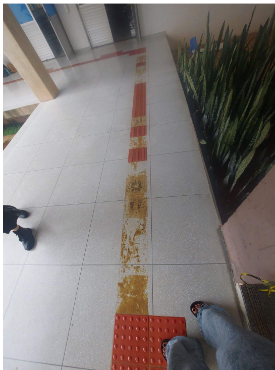
Figura n.º 11: piso tátil do prédio do Bloco de Salas Norte
