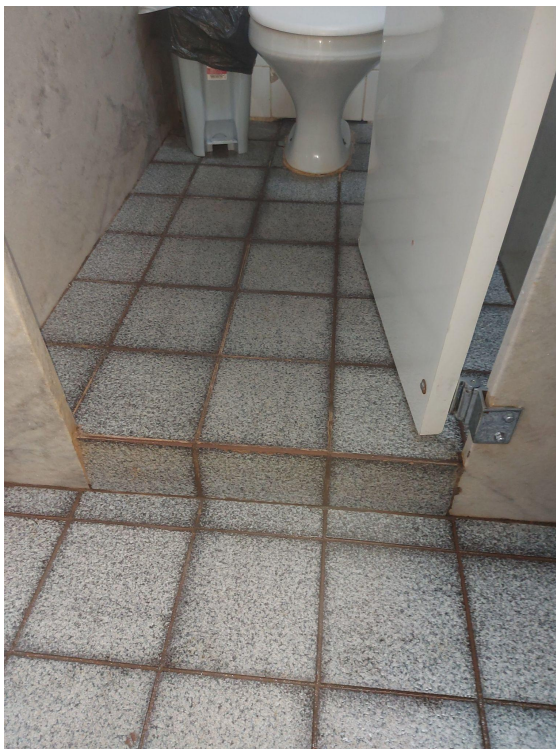
Figura n.º 10: banheiro feminino do Centro Acadêmico de Ciências Ambientais
