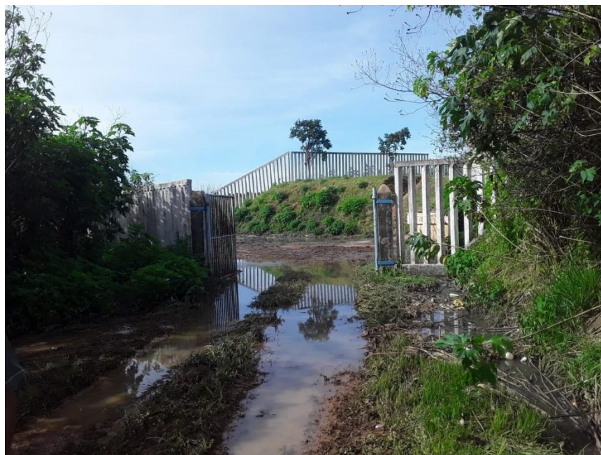
Figura 14. Imagem da Estação de Tratamento de Esgoto Melchior (Alzirenio Carvalho)
