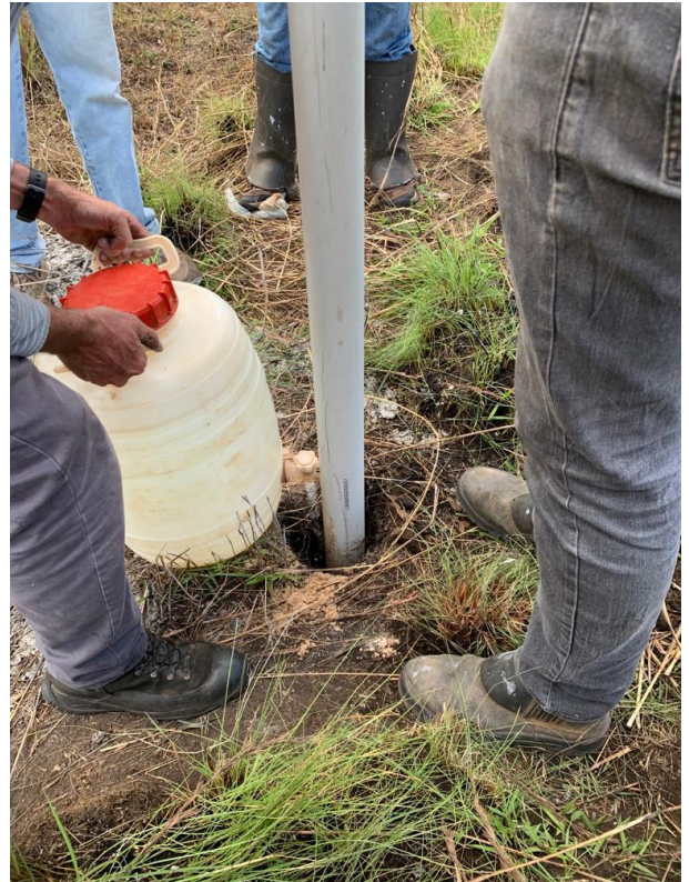
Figura 6 - Elementos básicos da construção do poço – Perfuração, Preenchimento do Espaço Anelar, Tampão, caixa de proteção e selo.
