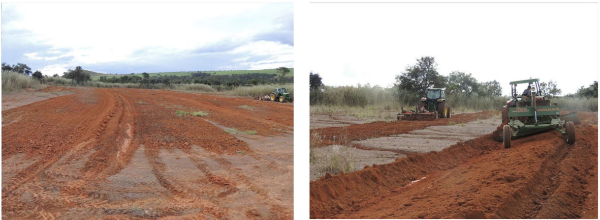
Figura 2. Vista geral da área de cascalheira (a) e preparo da área para plantio (b) na Fazenda Entre Rios no Paranoá, Distrito Federal.
