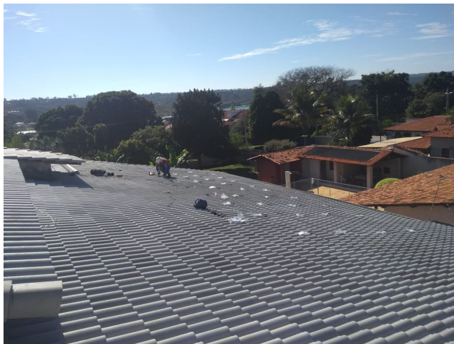
Figura 4.8. Imagem do telhado na avaliação para a instalação. (Autoria própria, 2019)
