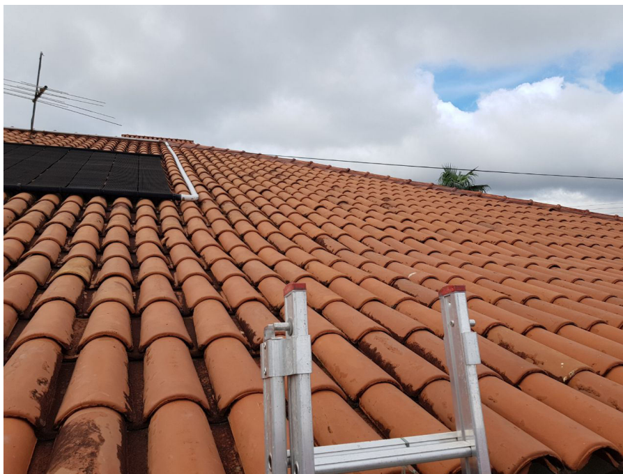
Figura 4.3. Imagem do telhado na avaliação para a instalação. (Autoria própria, 2018)
