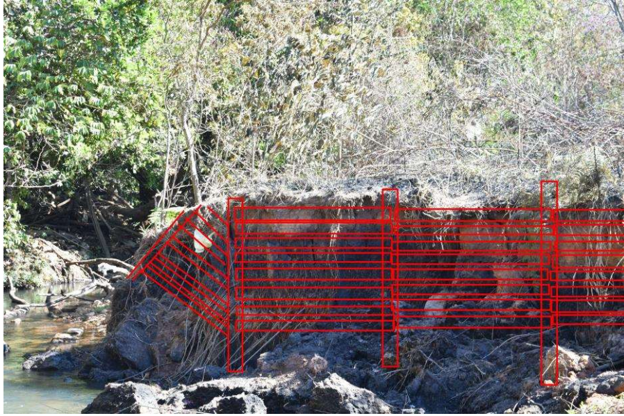
Figura 19. Aplicação da técnica de paliçada para conter a erosão fluvial sobre as margens do ribeirão. Imagem: Yuri Prestes
